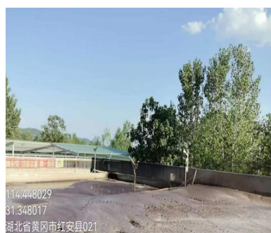
污水处理设施（AO池）
