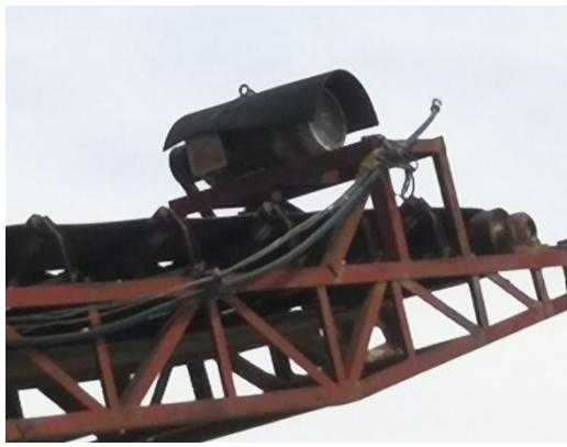
成品出料喷淋装置
